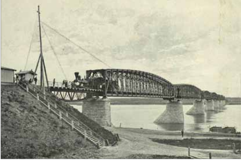
Мост через реку Обь.
