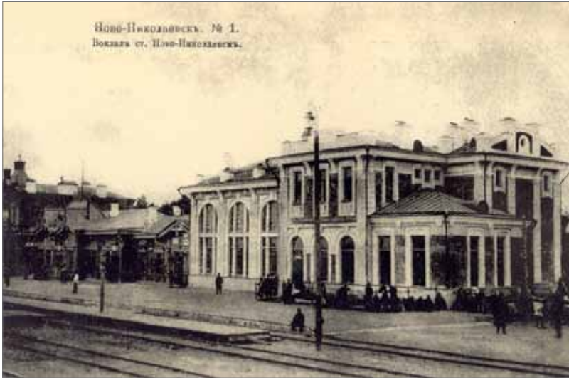
Вокзал станции Ново-Николаевск. 1915.
