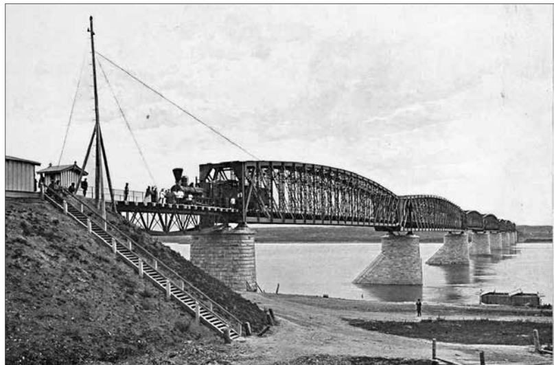
Мост через реку Обь.
