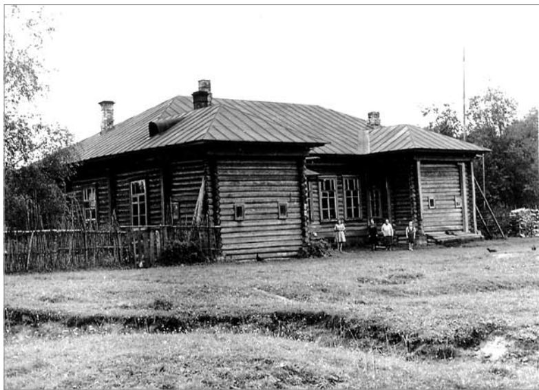
91. Здание земской тороповской школы. 1950 г.
