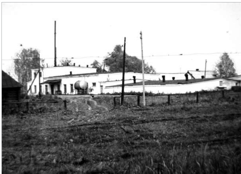
146. Сыродельный завод в Торопове на фундаменте барского дома.
