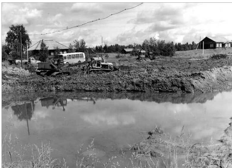
204. Земляные работы на месте будущего водоема. 2003 г.
